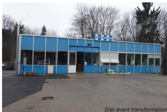
État avant transformation
